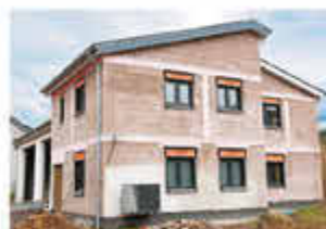
Betriebsgebäude im Entstehen Foto: O. Morguet
